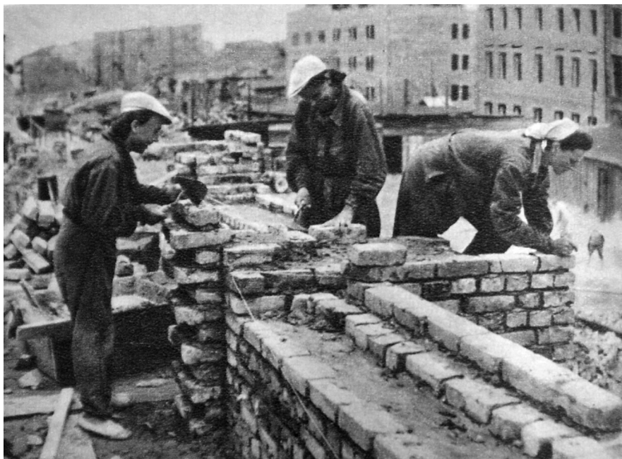
Budowa osiedla robotniczego na Mirowie w Warszawie. „Stanisława Kopielnicka i Kazimiera Molenda, budując nowym systemem zespołowym, ustanowiły kobiece rekord budowy, który jest wyższy od przeciętnej wydajności mężczyzn, pracujących starym systemem” („Kobieta” 1949, nr 29)
