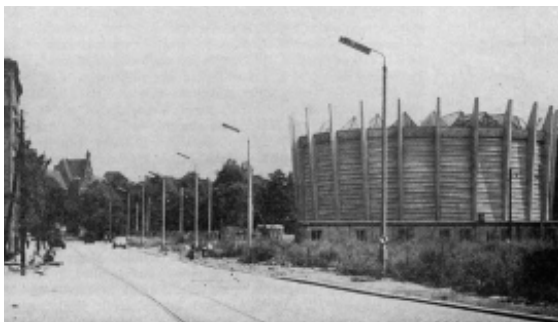
Ulica Purkyniego, rotunda Panoramy Raclawickiej w budowie, rok 1969
