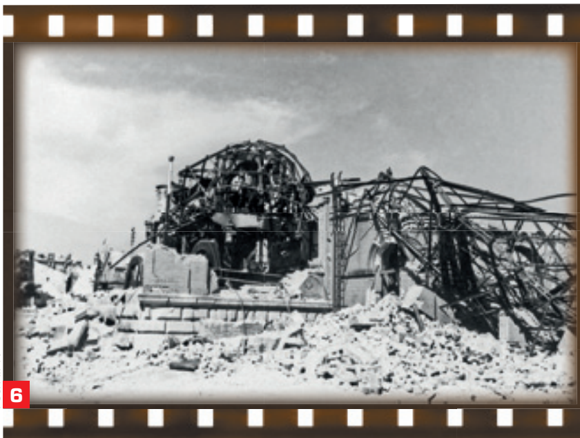
► Ruiny stacji pomp przy ul. Czerniakowskiej; 1945 rok
